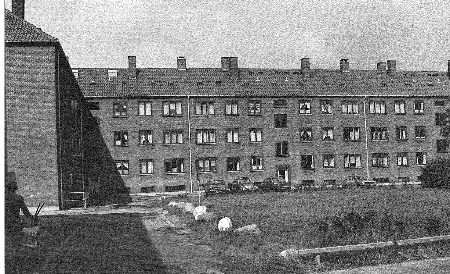
Figur 2. Fotografi af blok 2 set fra gårdsiden.
